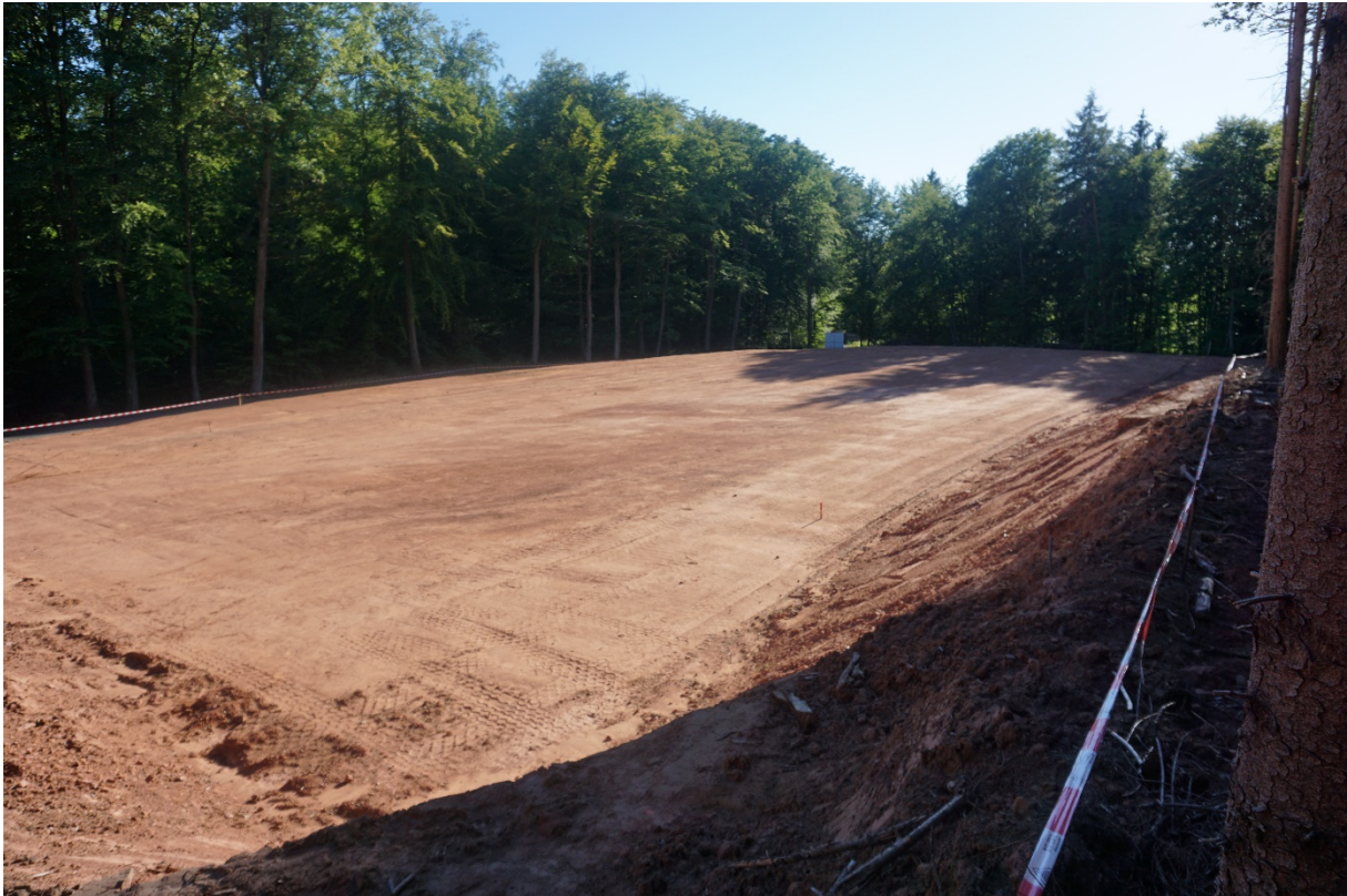
Foto: Bauplatz für zwei Wasserbehälter von Pharmaserv im Marbacher Wald / 31.07.2020
